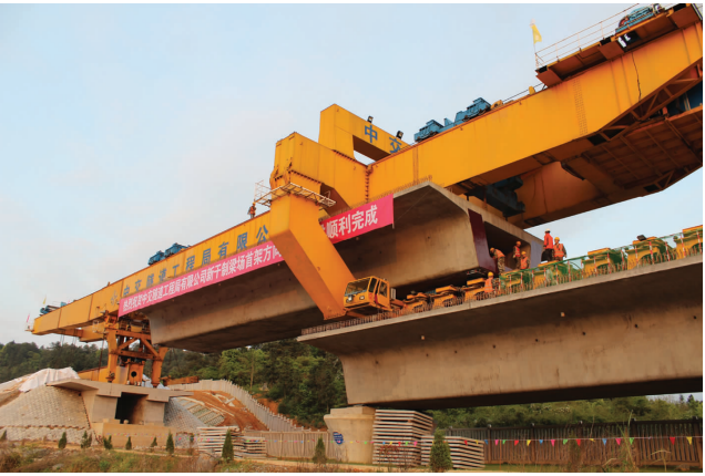
4月12日,随着杨家坊特大桥最后一孔箱梁稳稳落下,昌赣客专项目部完成标段内首架方向全部317孔箱梁架设任务。(万应强)
