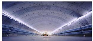
统筹兼顾，下好工作“先手棋” 南京和燕路过江通道南段隧道工程是全国首例超大直径盾构穿越断层、岩溶地层的过江隧道，施工中需短距离内穿越地层跨度大、地质软硬不均多种地层，同时还需穿越多条断裂带。隧道在江底最高水深79米，水压0.79兆帕，被钱七虎等院士和业内专家认定为“迄今为止长江上最难建造的过江隧道”。
